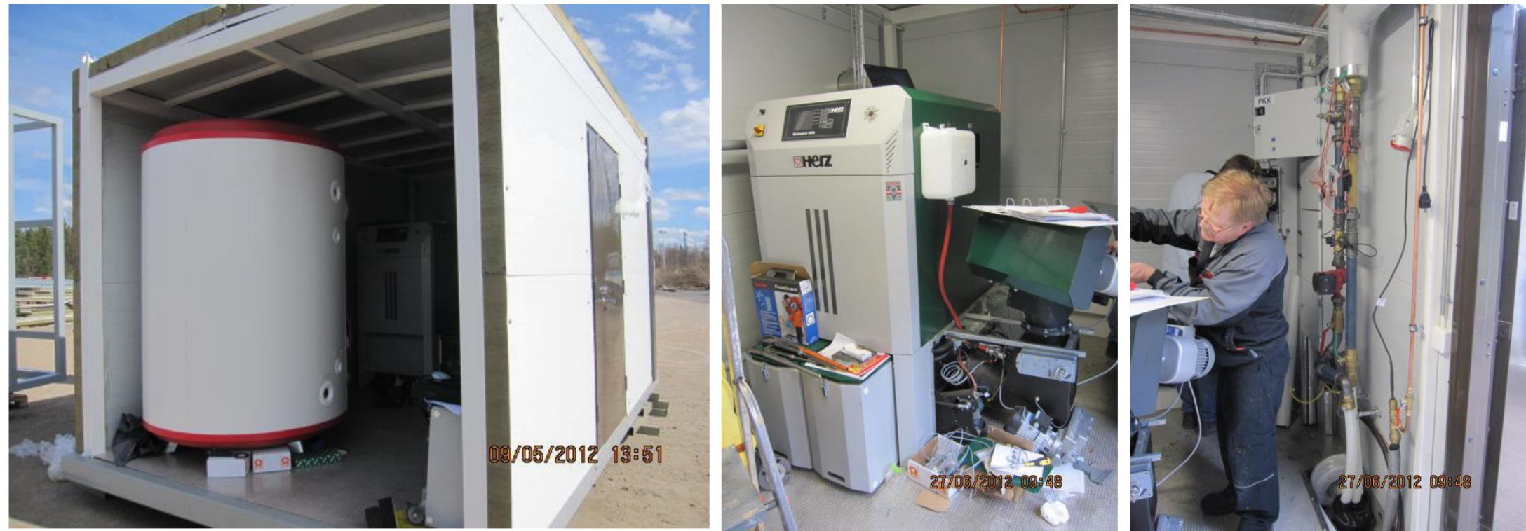
Kuva 3. Lämminvesivaraajan ja Herz Firematic biomassakattilan asentaminen kattilahuoneeseen
